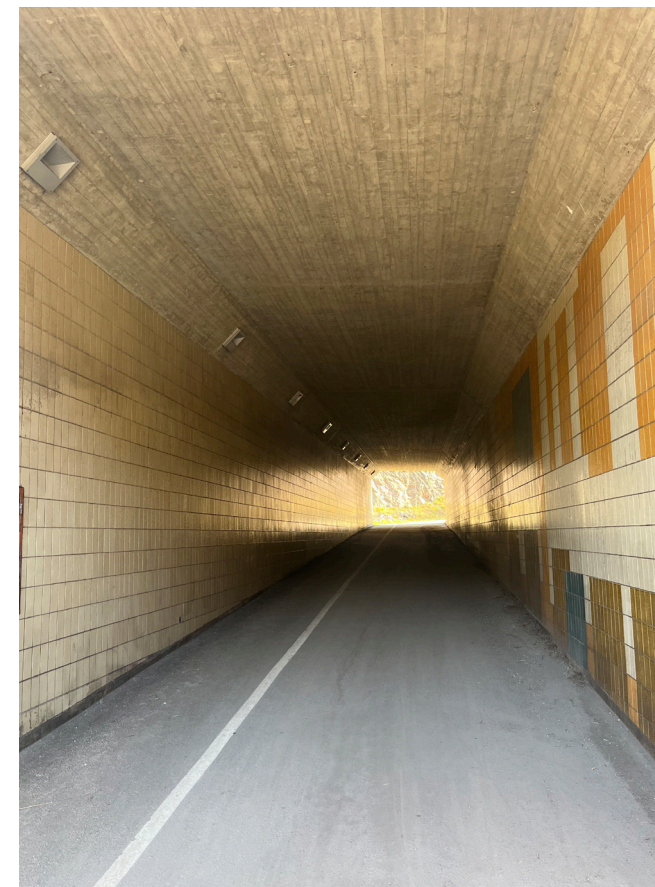
Figur 25. Gångtunnel under Värmdöleden
